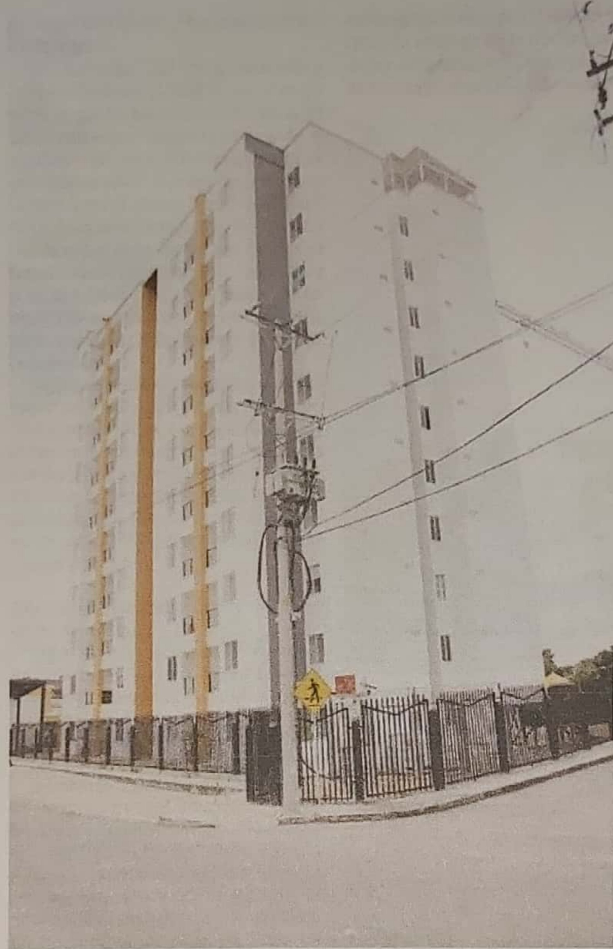
En la torre 1, que ya se encuentra construida, hay algunos propietarios viviendo, sin embargo Planeación no ha dado permiso de habitabilidad.
